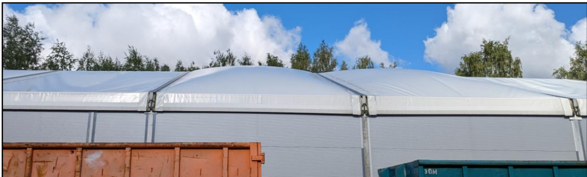
Abbildung 1: Erste Ausprägung der charakteristischen Wölbung im Befüllbetrieb in den Zeltkammern am Druckaggregat
